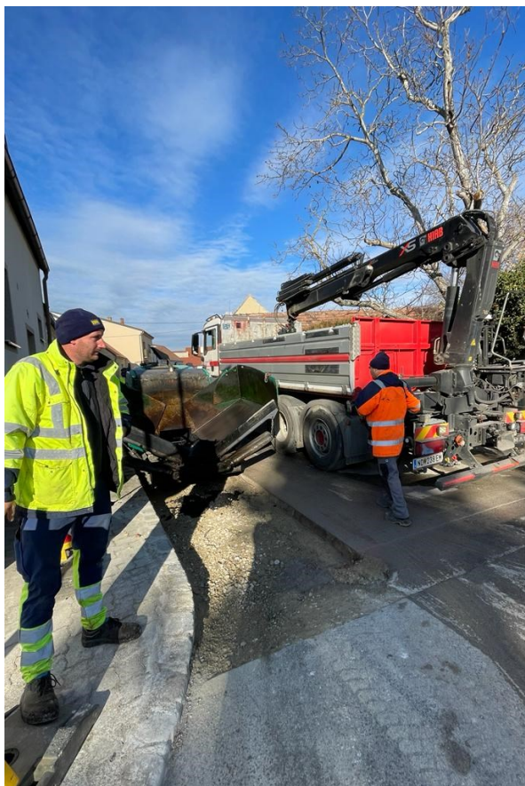
Wiederherstellung durch Firma Porr in der Seestraße
